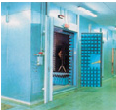
Figura 1: Laboratorio di Test: Camera Anecoica
